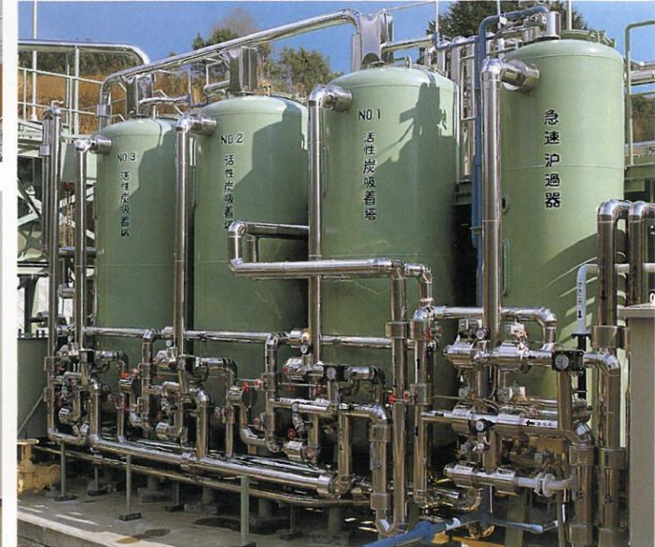
●砂ろ過処理設備と活性炭吸着処理設備
