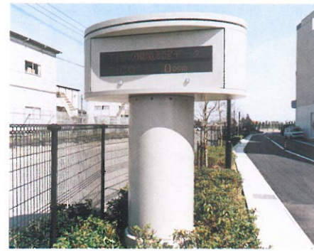
公害監視表示盤 Pollution Indication Board
