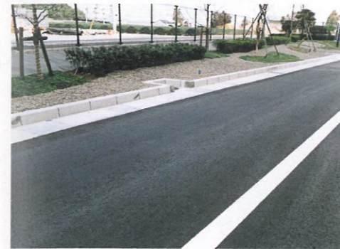
スラグ入アスファルト舗装 ( 搬入道路 ) Slag mixed Asphalt ( Road in the Plant Site )
