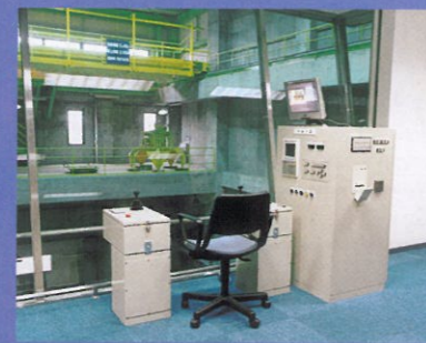
不燃ごみクレーン操作室 Bulky Waste Crane Operation Room
