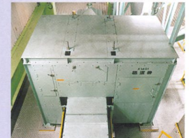
磁選機 Magnetic Separator
