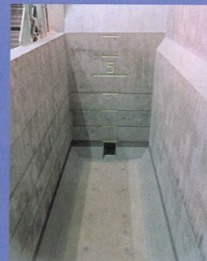
不燃ごみピット Incombustible Waste Bunker
